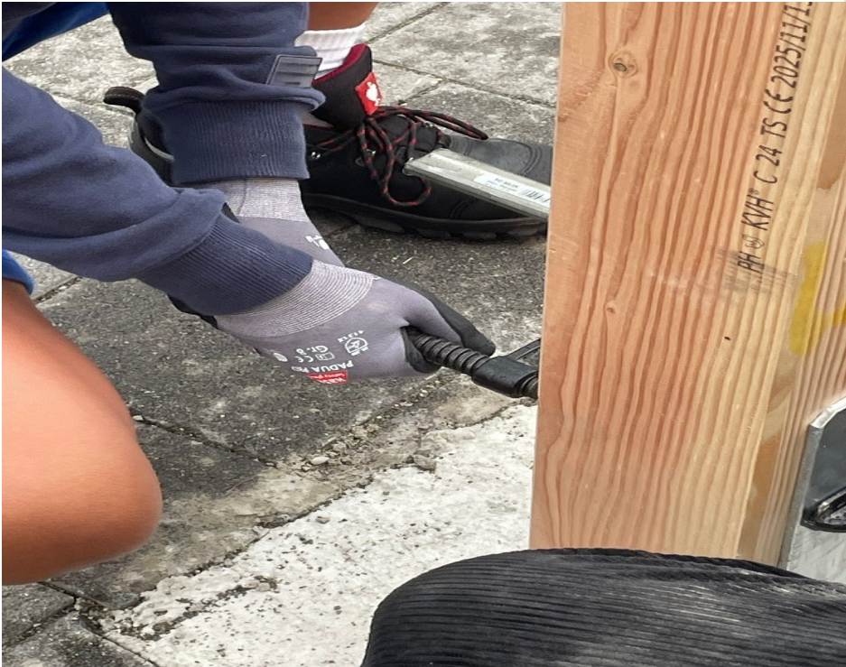
5.3 Gemeinsames Ausrichten und Verschrauben der Rahmenelemente.
