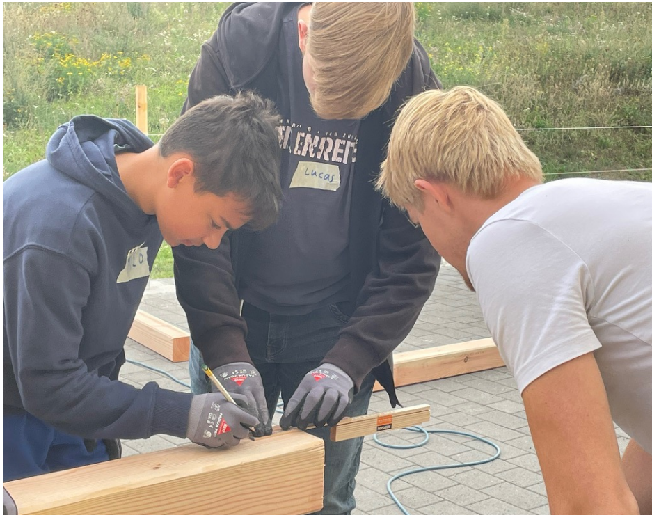
3.1 Maße und Montagepunkte werden auf den Holzbalken übertragen und angezeichnet.
