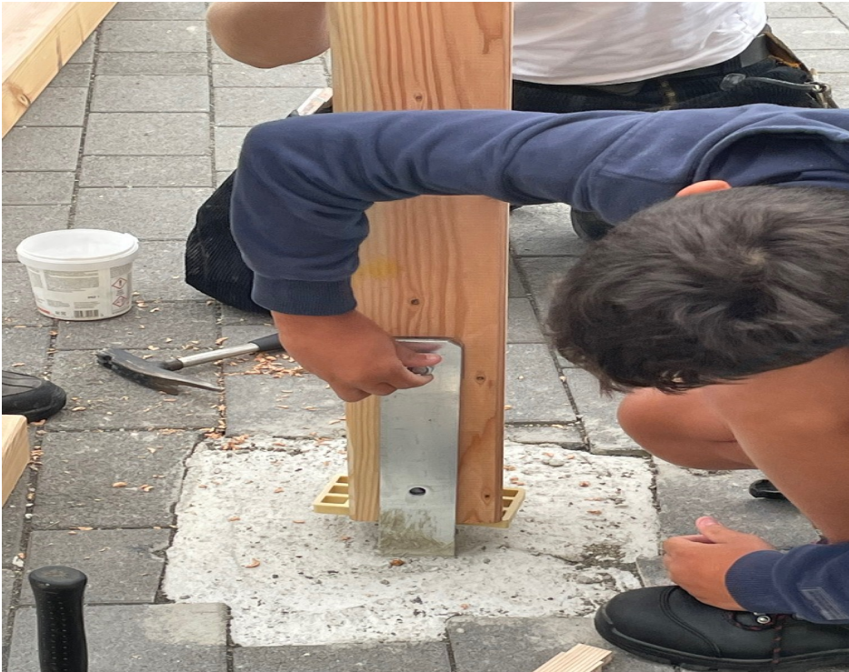
4.1 Kontrolle der Verbindung zwischen Betonfundament, Metallhalterung und Holzpfosten.
