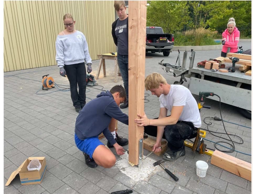
4.2 Der Holzpfosten wird in der Metallhalterung ausgerichtet und mit dem Fundament verbunden.
