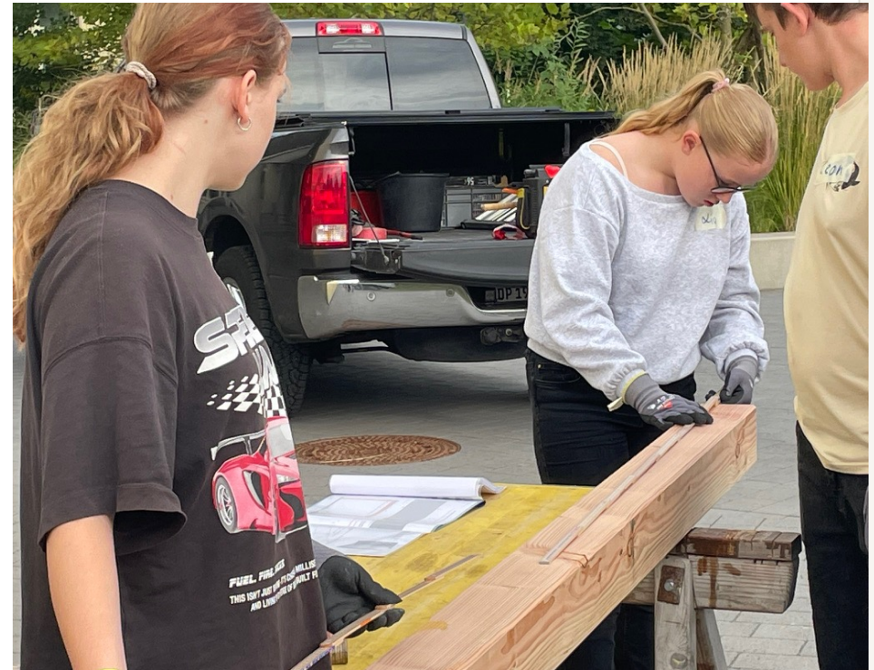
3.2 Exaktes Vermessen der Bauteile vor Zuschnitt und Montage.
