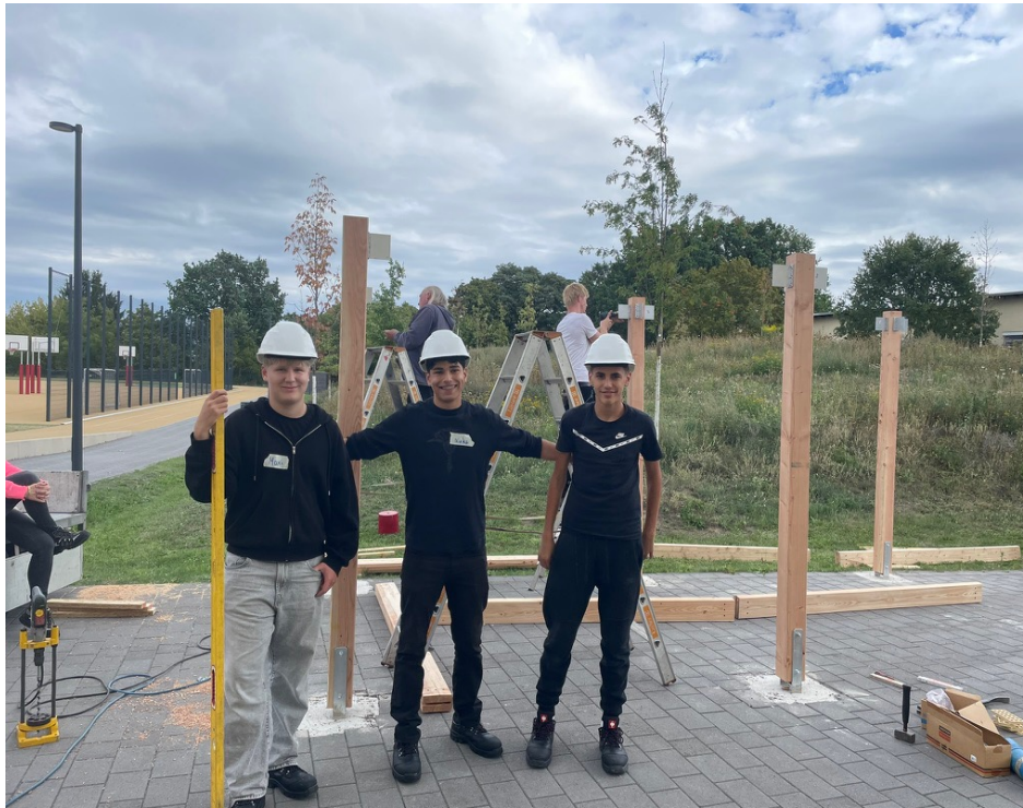
1.3 Das Montageteam übernimmt die verschiedenen Aufgaben beim Aufbau der Konstruktion.
