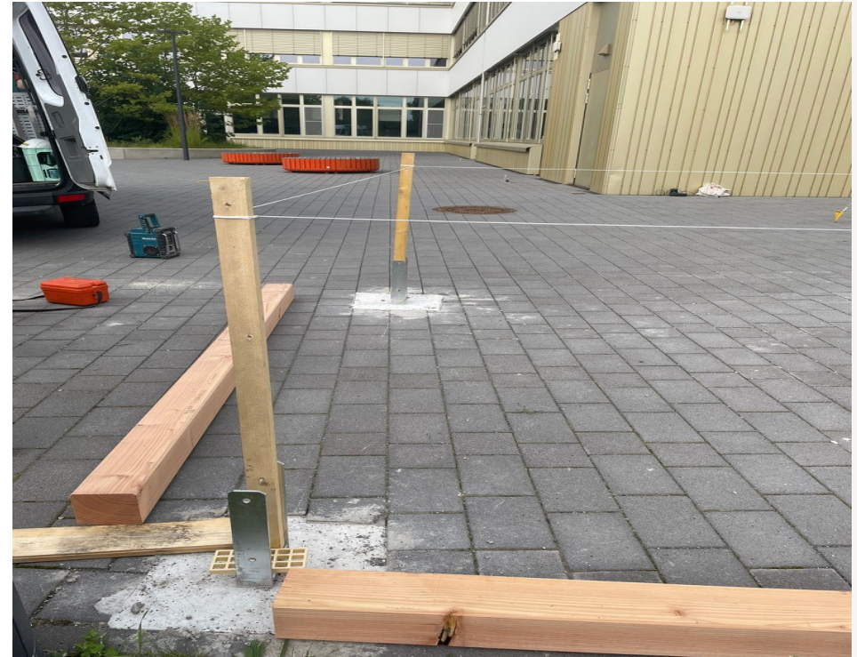
2.2 Kontrolle der Höhen an den vorgesehenen Montagepunkten.
