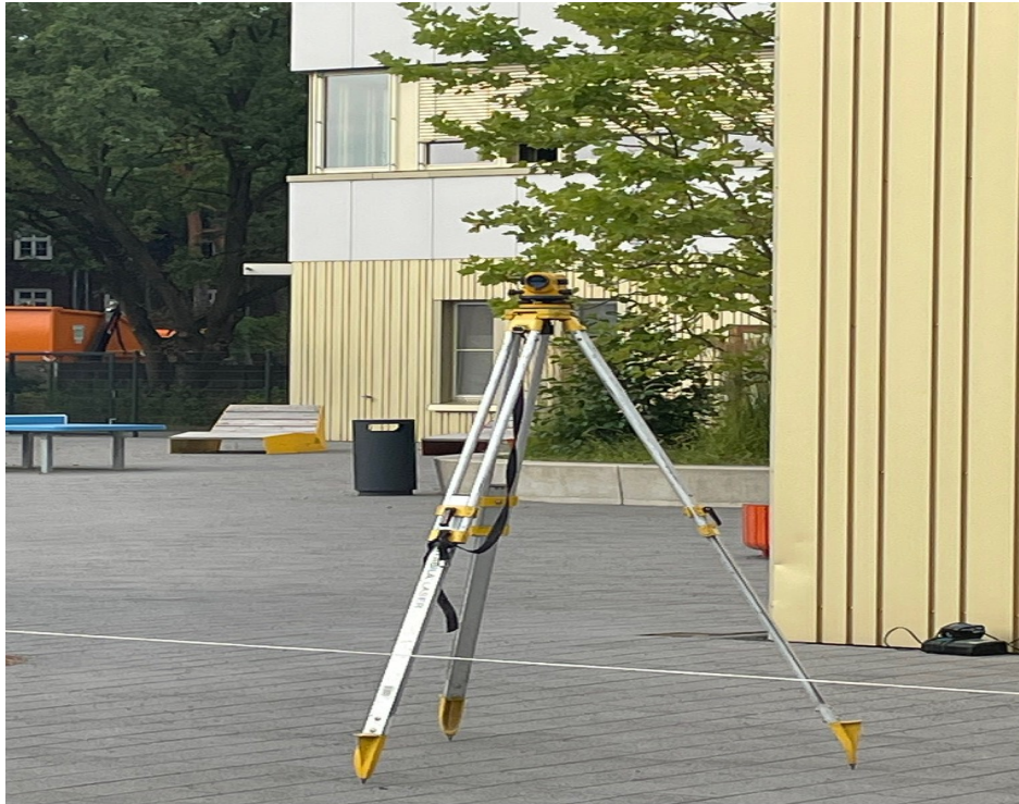
2.1 Vermessung des Geländes zur Ermittlung von Höhenunterschieden und Gefälle.
