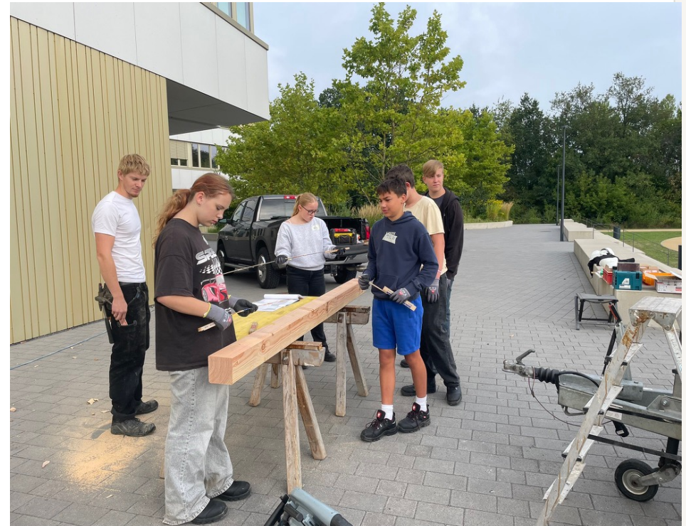
3.4 Schnitt- und Kantenbereiche werden bearbeitet und für die Montage vorbereitet.
