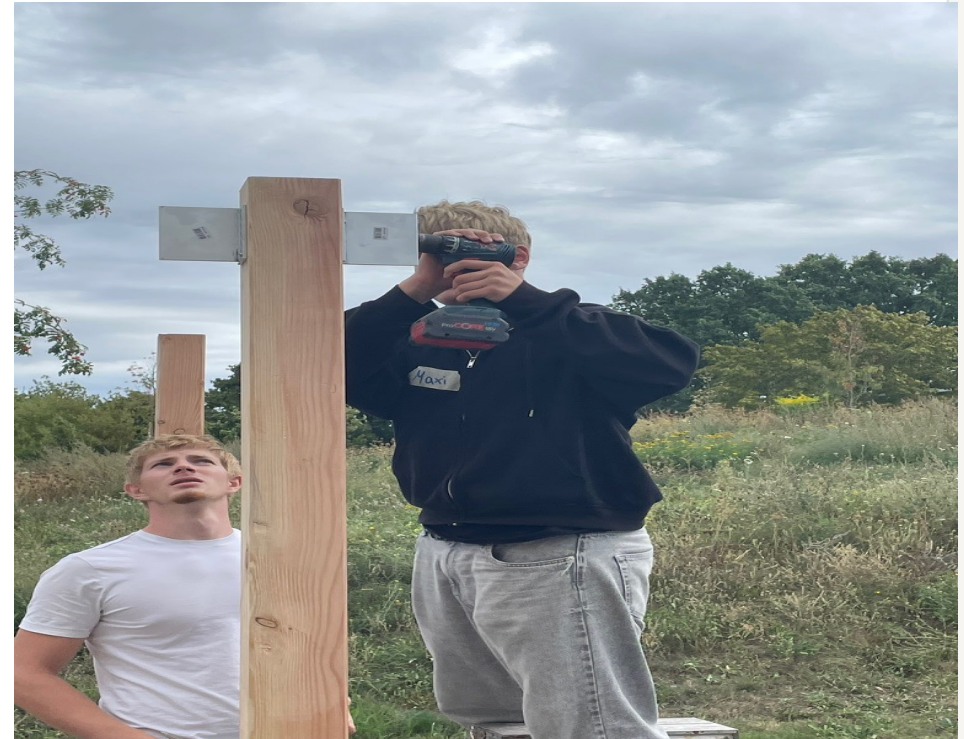
4.4 Montage und Verschraubung der Halterung für den späteren Querträger.
