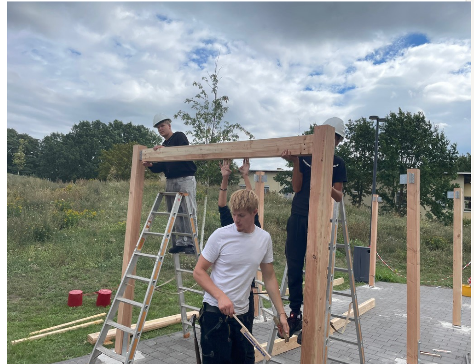
5.2 Einsetzen und Befestigen eines Querträgers zwischen den Pfosten.
