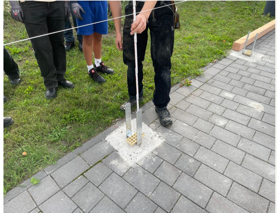
2.4 Ermittelte Höhen werden auf die erforderlichen Balkenlängen übertragen.
