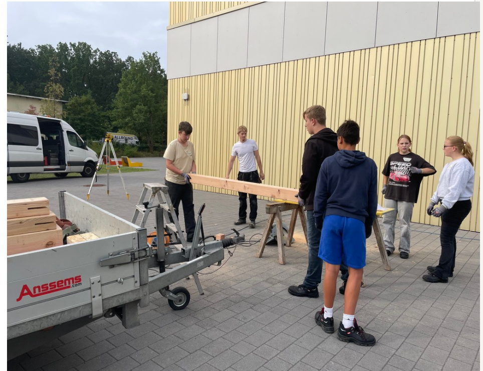
1.2 Anlieferung und Transport des Materials zur vorbereiteten Montagefläche.
