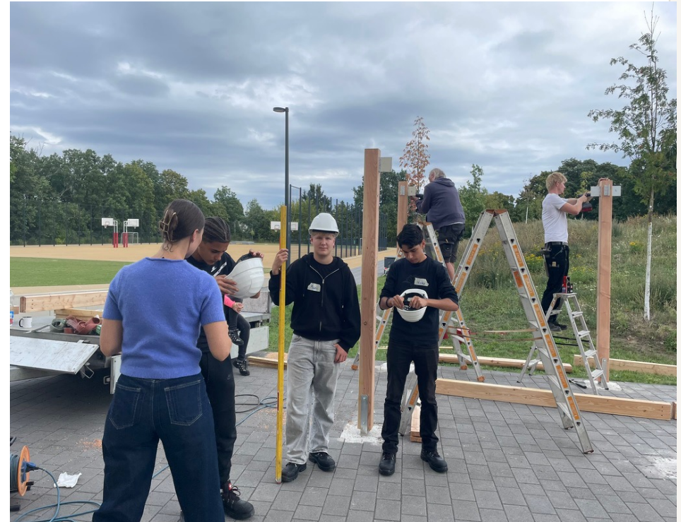
5.4 Kontrolle von Befestigungen, Ausrichtung und Standsicherheit der montierten Konstruktion.
