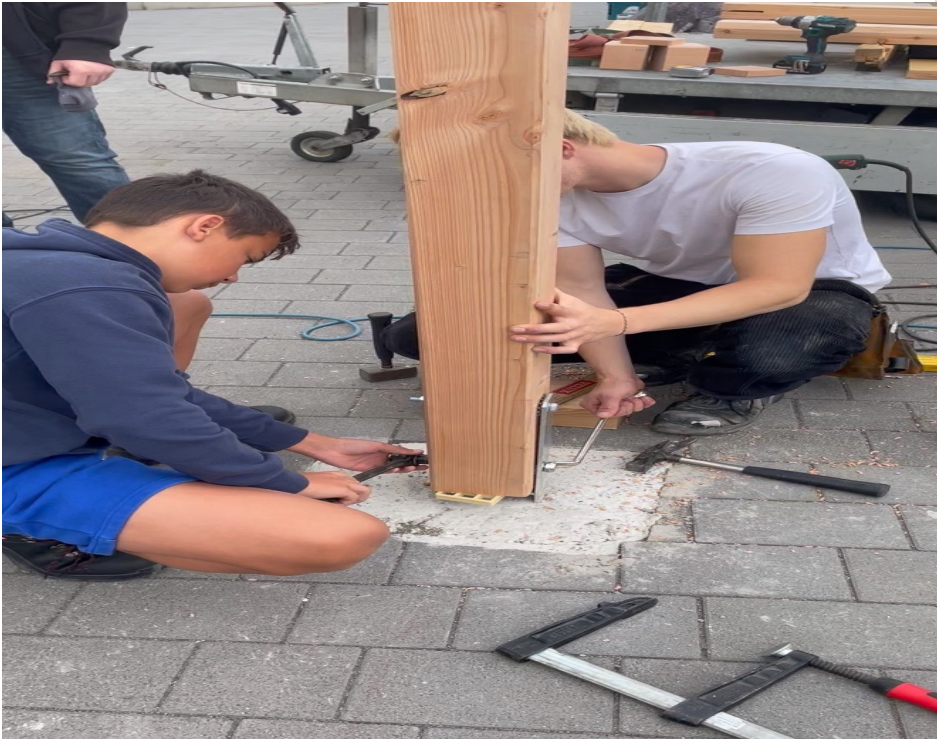
4.3 Schrittweise Verschraubung des Konstruktionsbalkens an der im Fundament verankerten Halterung.
