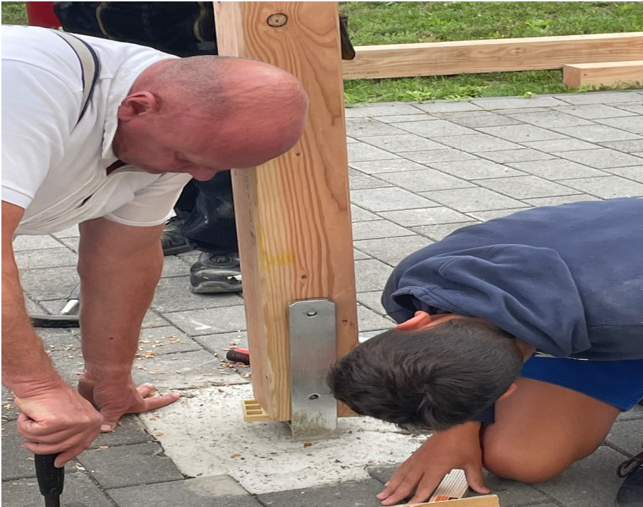
2.3 Überprüfung von Bodenabständen und Höhen für die spätere Ausrichtung.
